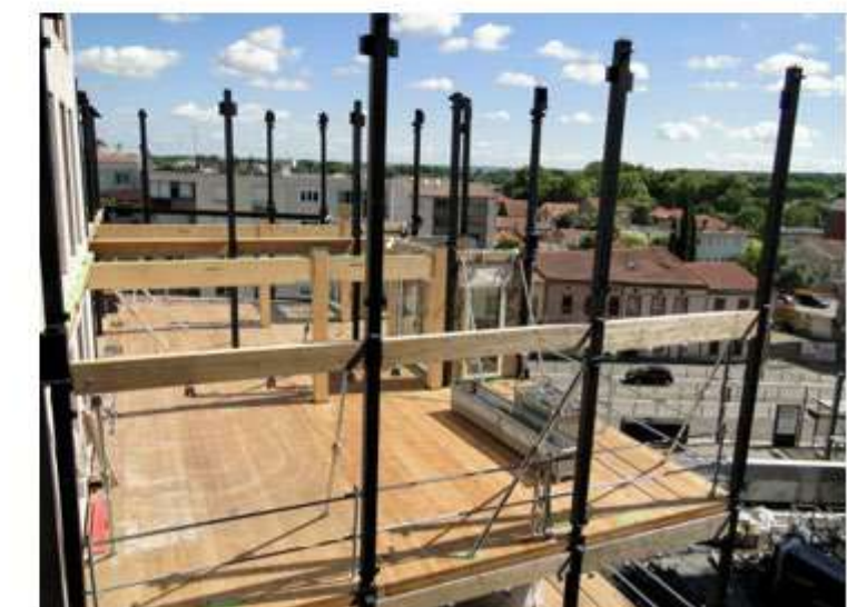
Structure porteuse bois-métal (juillet 2021)
