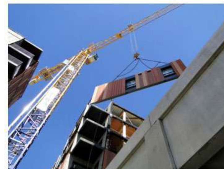
Façades ossature bois préfabriquées (juillet 2021)
