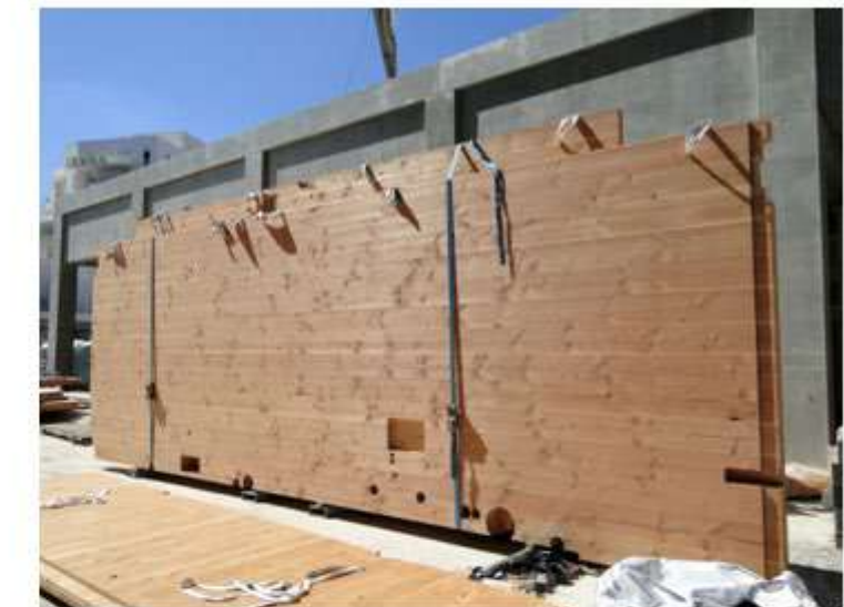
Planchers en CLT avec réservations faites en usine (juillet 2021)
