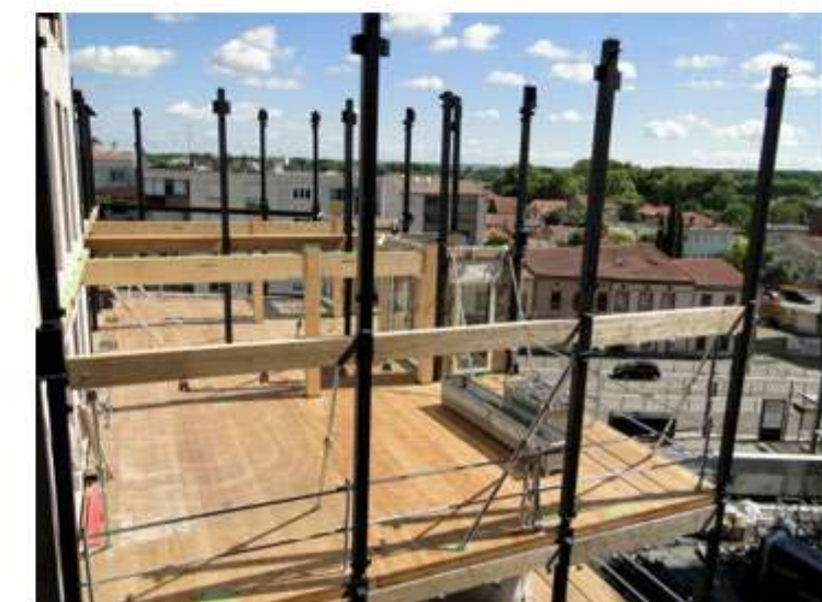
Structure porteuse bois-métal (juillet 2021)
