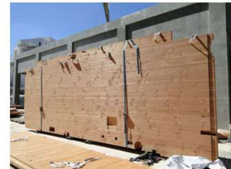
Planchers en CLT avec réservations faites en usine (juillet 2021)
